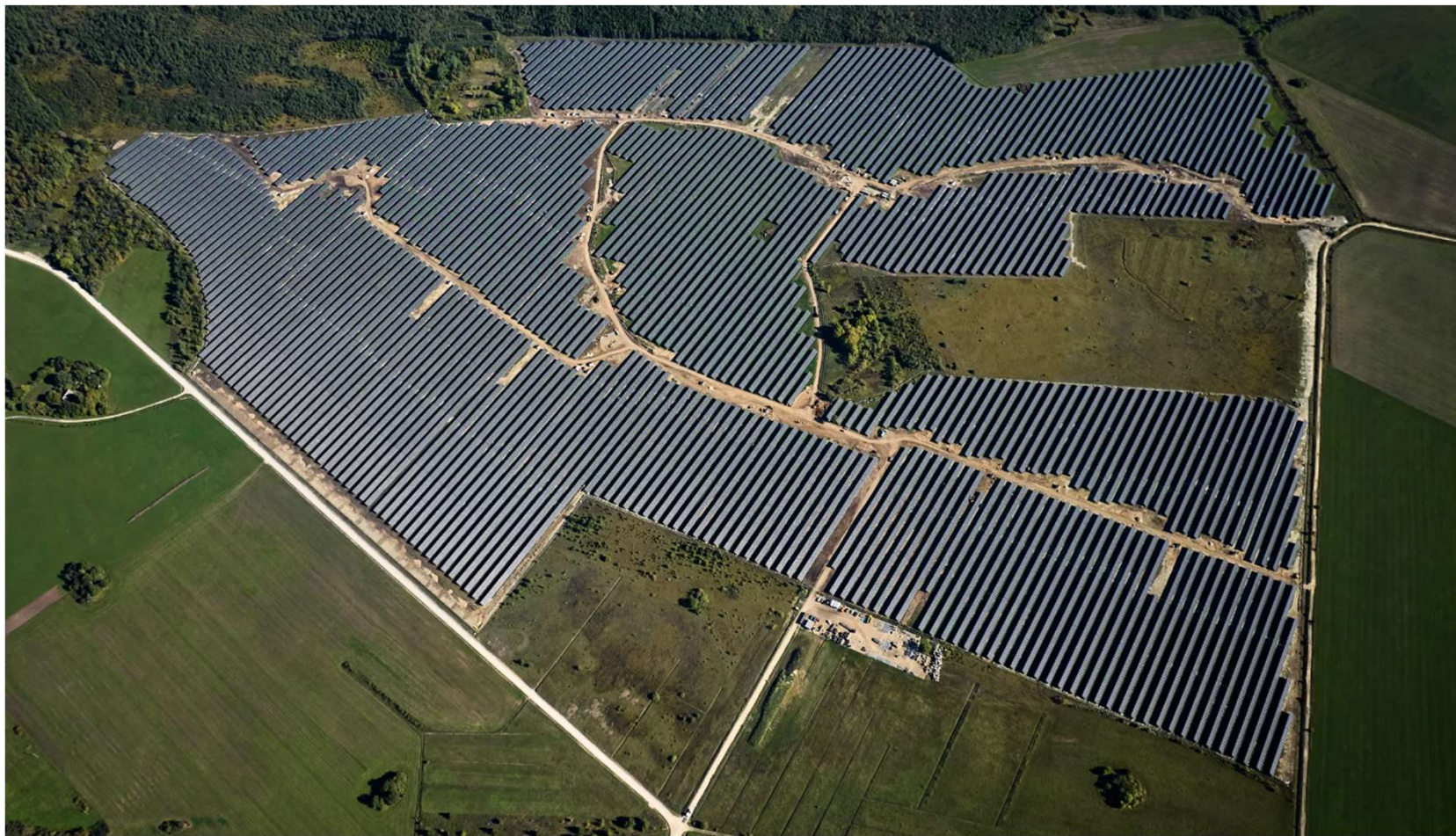
Evecon OÜ Kirikmäe päikeseпарк 77,53MW
